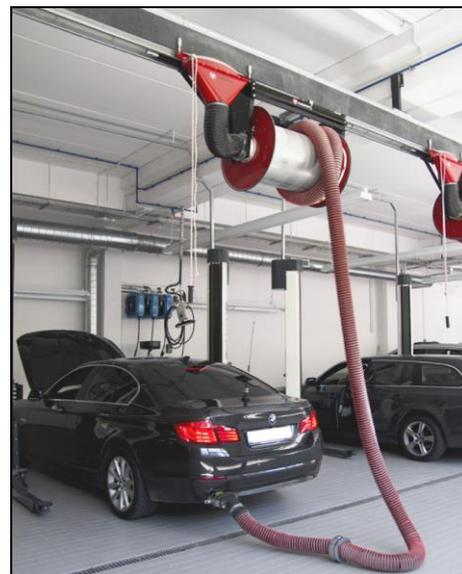
**Utilisation :** Ce dispositif Modèle KOS-L-ALAN est prévu pour la captation et l'évacuation des gaz d'échappement sur tous types de véhicules. L'enrouleur est fixé sur un rail d'aspiration et permet ainsi l'aspiration en tous points sur la longueur du rail. L'enrouleur peut être équipé de flexible diamètre 100, 125 ou 150 suivant le débit d'aspiration désiré. Deux modèles de tambour permettent l'enroulage de 8 ou 12 mètres de flexible.
