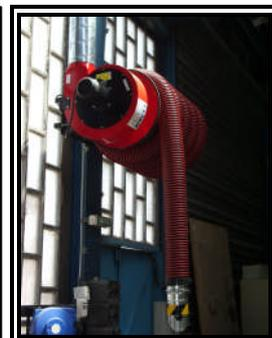
Un ventilateur d'extraction spécifique peut être fixé directement sur l'enrouleur. Mais l'enrouleur peut aussi très bien être relié à un ventilateur indépendant ou à une tourelle d'aspiration fixée sur le toit.
